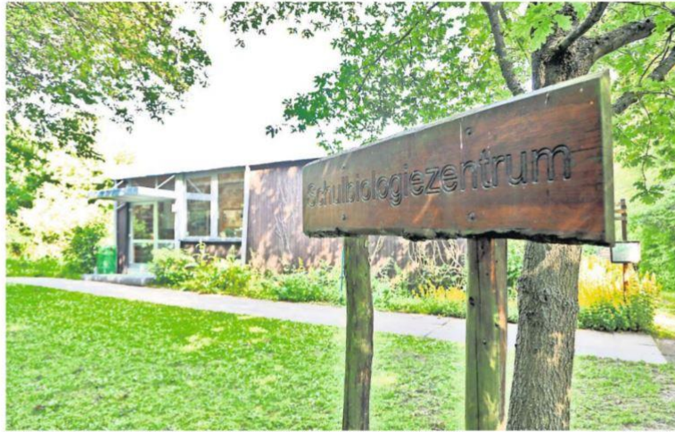
Das Gebäude im Schulbiologiezentrum ist marode und muss saniert werden – darüber herrscht kein Zweifel.
